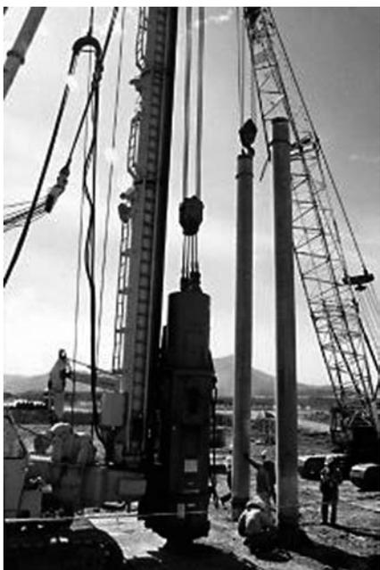
圖 6-4-6 蘆洲機廠打設 PC 樁進行焊接作業（田潔生攝）
